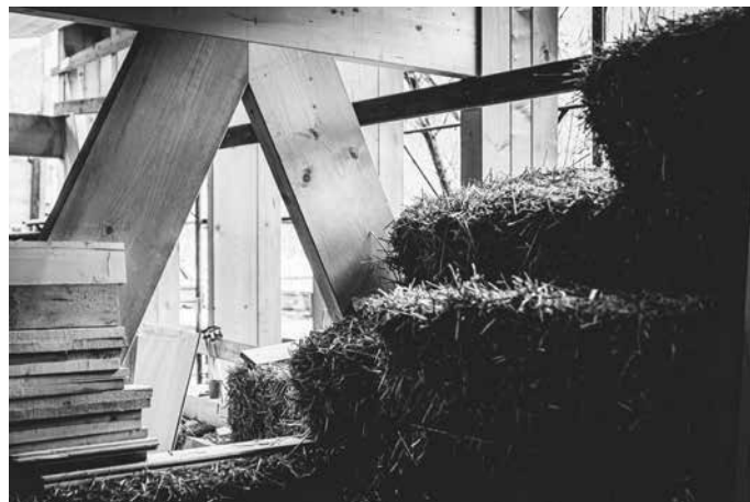
Particolare del cantiere | detail of the site, Braccano, 2019.
