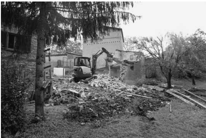
Demolizione e rimozione delle macerie | Demolition and removal of rubble, Braccano, 2018.
