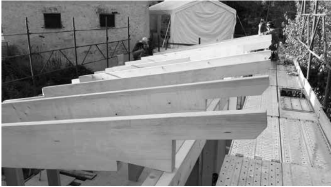
Posa in opera delle travi della casa in paglia | Installation of the straw house beams, Braccano, 2019.
