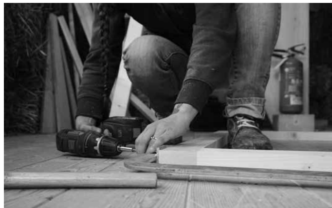
Una delle fasi della costruzione della struttura in legno | One phase of the building of the wooden structure, Braccano, 2019. Autoscatto | Selfie.
