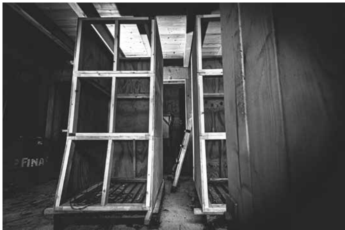
In Domum , struttura in legno delle colonne | wooden structure for columns, Braccano, 2019.
