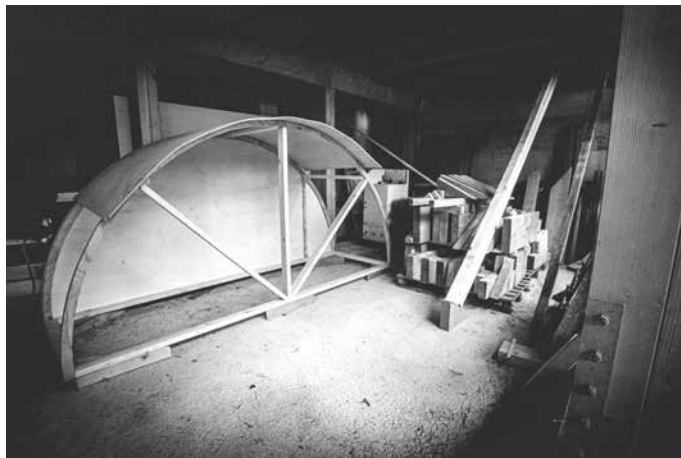
In Domum , struttura in legno dell'arco | wooden structure for the arch, Braccano, 2019.
